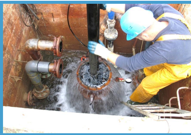
Diagnostic d'un forage de 680m (aquifère des grès du Trias inférieur)
